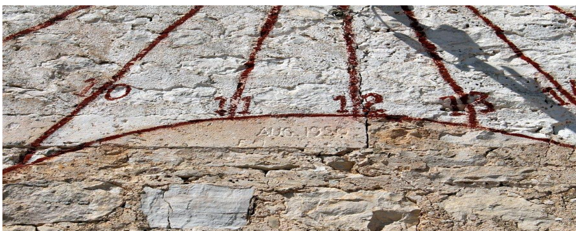
Sunčani sat na fasadi pomoćne zgrade i uklesan datum izvedbe
