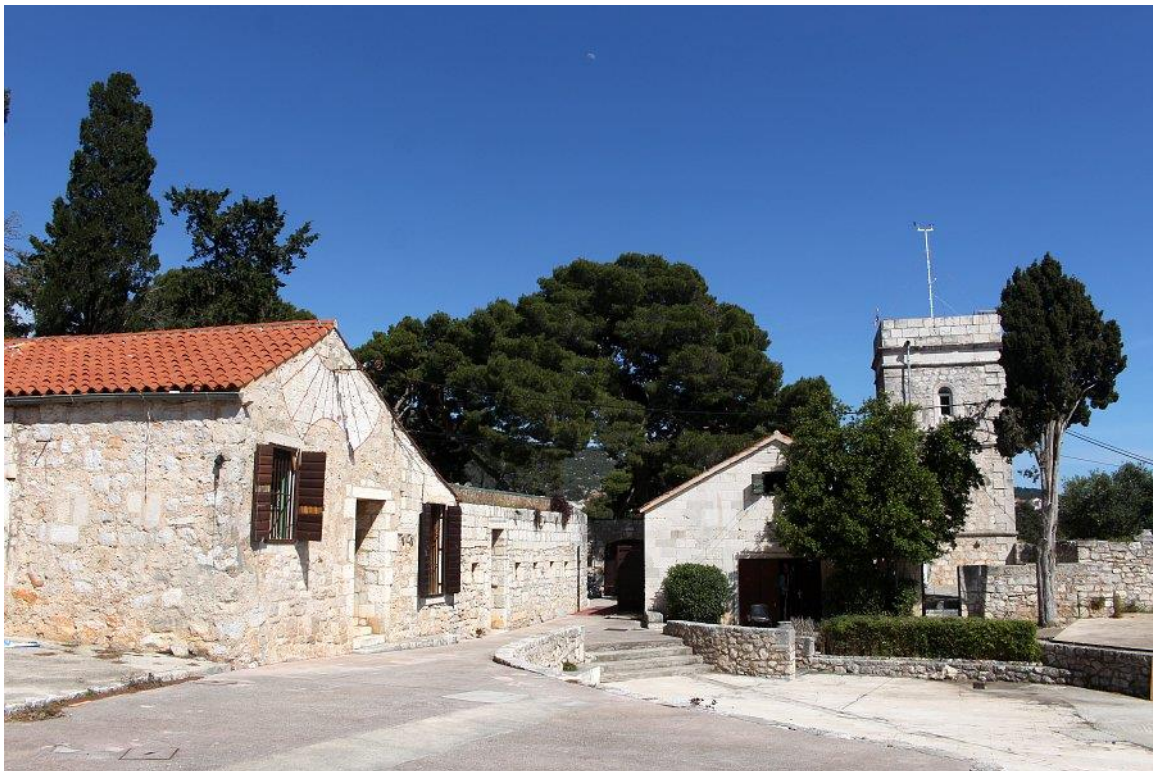
Pogled na zgradu sa sunčanim satom i dio dvorišta Venerande
